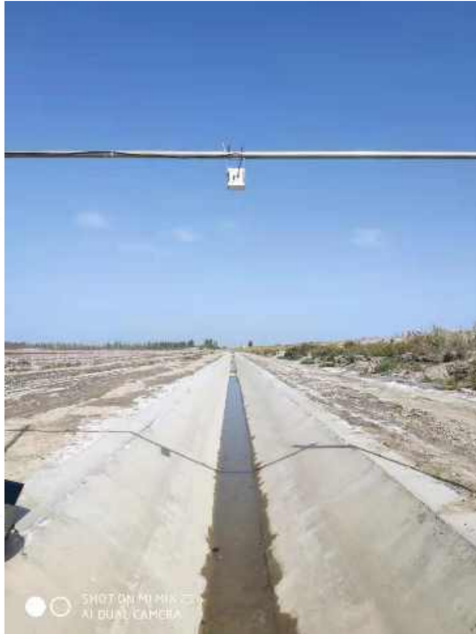
西南灌区沟渠流量监测
